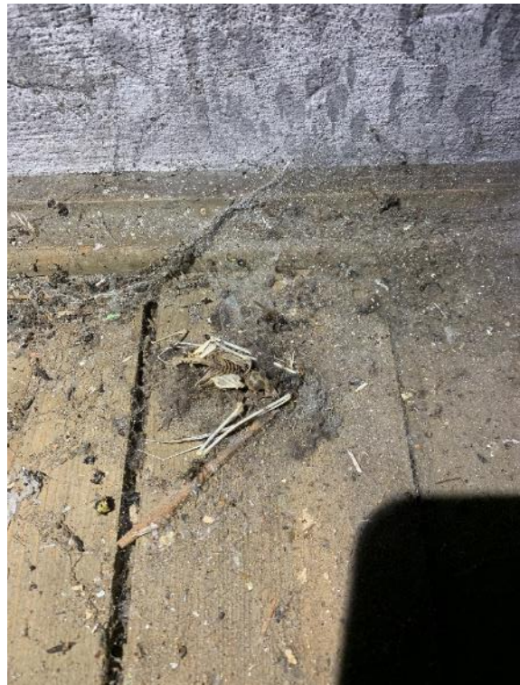
Abbildung 9: Tote Meise auf dem Dachboden.
