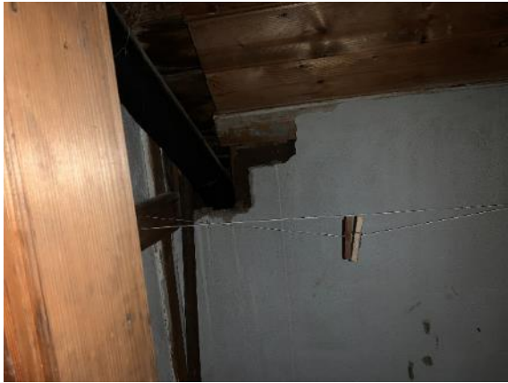
Abbildung 22: Potenzieller Lebensraum für Fledermäuse auf dem Dachboden.
