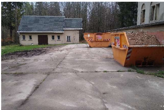
Foto 9: Versiegelte Fläche zwischen Großem Haus und ehem. Hühnerstall
