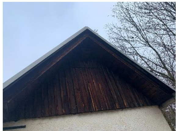
Abbildung 31: Bretterschlag an Gebäude "Hühnerstall".
