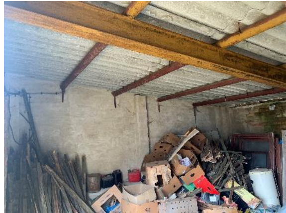
Abbildung 34: Abbildung eines Abteils der Garage 1.
