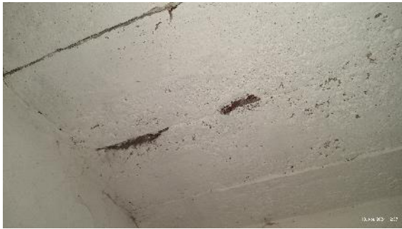
Abbildung 28: Etwa 3 cm große Spalte im Hauptraum des Hühnerstalls. Foto: M. Hurtig
