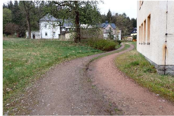
Foto 8: Teilversiegelter Weg am „Kleinen Haus“
