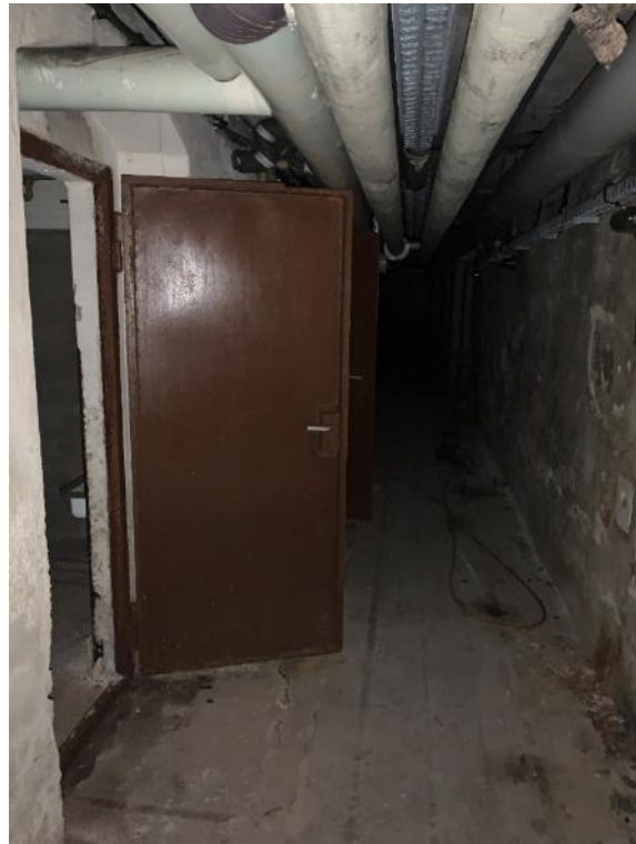
Abbildung 16: Kellerflur im „Großen Haus“.
