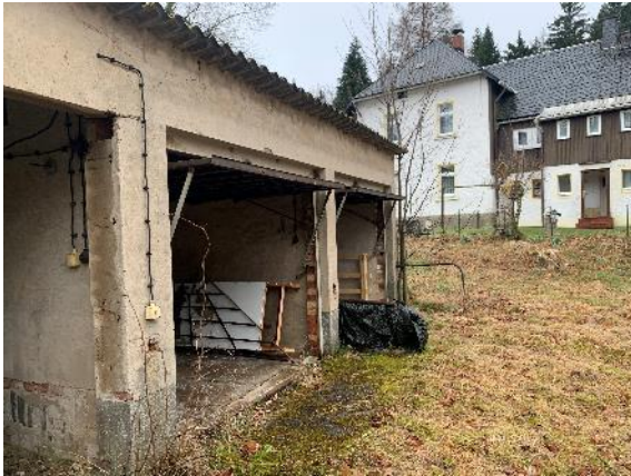
Abbildung 33: Vorderansicht der Garage 1.
