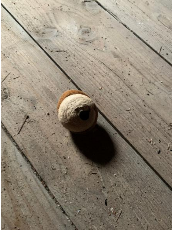
Abbildung 10: Altes Wespennest auf dem Dachboden.
