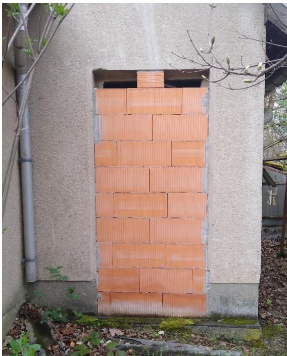
Abbildung 30: Einflugmöglichkeit in unbegehbaren Teil des Hühnerstalls. Foto: M. Hurtig
