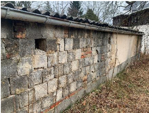
Abbildung 35: Rückseite der Garage 1.
