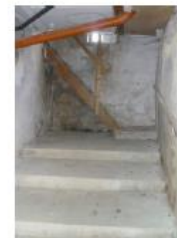
Treppenaufgang am Nordgiebel
